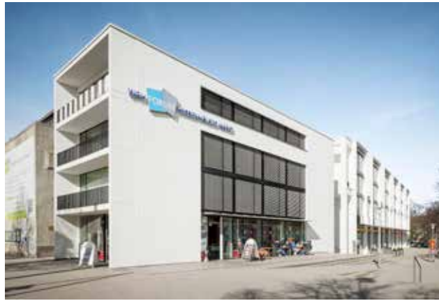
Das erste gebaute Wohn- und Geschäftshaus aus einer anderen Perspektive. Im Hintergrund rechts steht der zweite Bauabschnitt mit dem großflächigen Einzelhandel und den darüberliegenden Wohnungen
