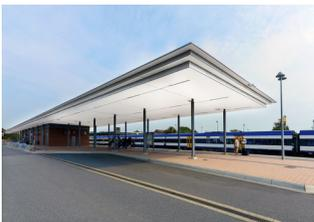
hierzu gibt es auf dem mittelbahnsteig ein zweites neugebautes dach. es schützt den treppenzugang vom bahnhofstunnel, den aufzug und die wartebereiche der bahnsteige nr. 2 und 5. seine kanten folgen der gleisgeometrie, wodurch es eine leichte trapezform erhält. mit einer länge von 43,27 m und einer breite, die von 16,67 m bis zu 18,01 m variiert, entsteht hier eine gesamtfläche von 769,86 m<sup>2</sup>.
