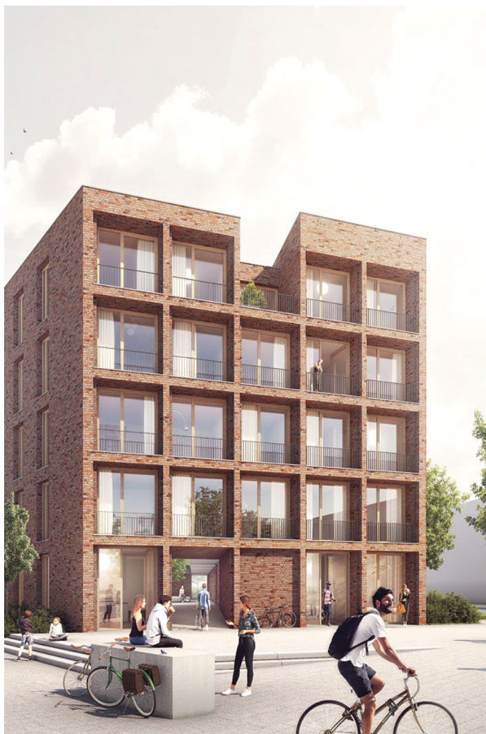
areal mitte - baufeld b.6
