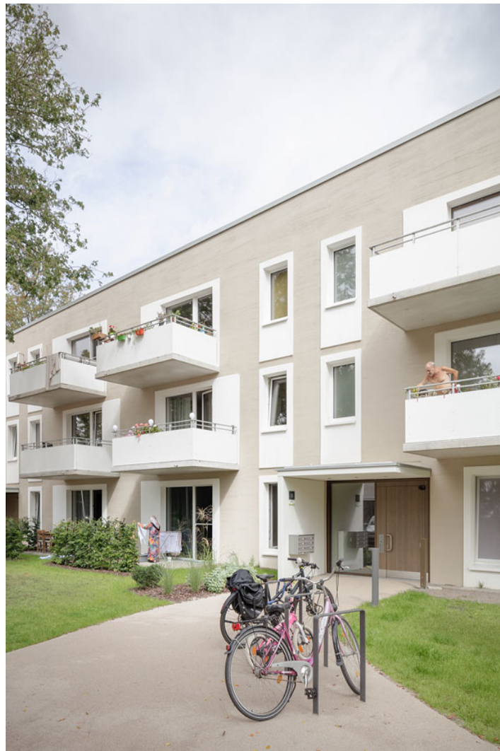
wohnanlage trautenauer hof
