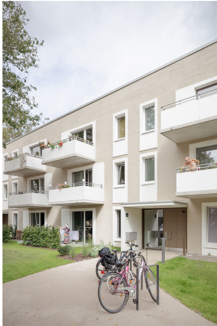
wohnanlage trautenauer hof
